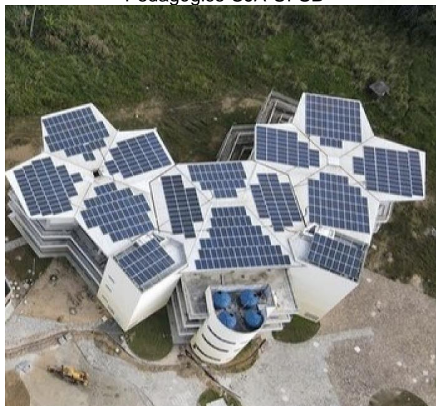
Figura 4. Vista da cobertura do Bloco Pedagógico CJA-UFSB
