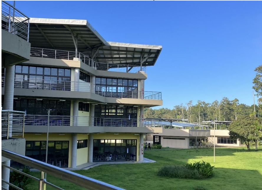
Figura 3. Vista do Bloco Pedagógico CJA-UFSB a partir da rampa de acesso aos pavimentos
