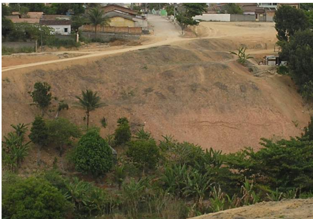
Figura 12. Encosta afetada por voçorocamento após trabalho de terraplanagem.
