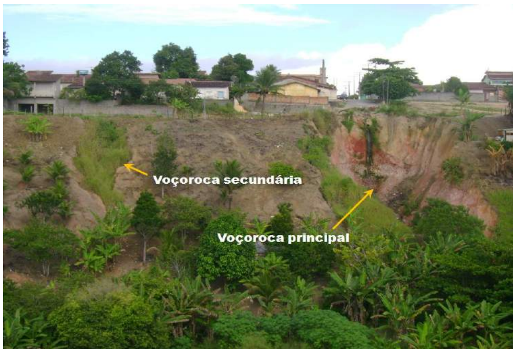
Figura 08. Encosta afetada por voçorocas no bairro Urbis I – Eunápolis (abr/2008).
