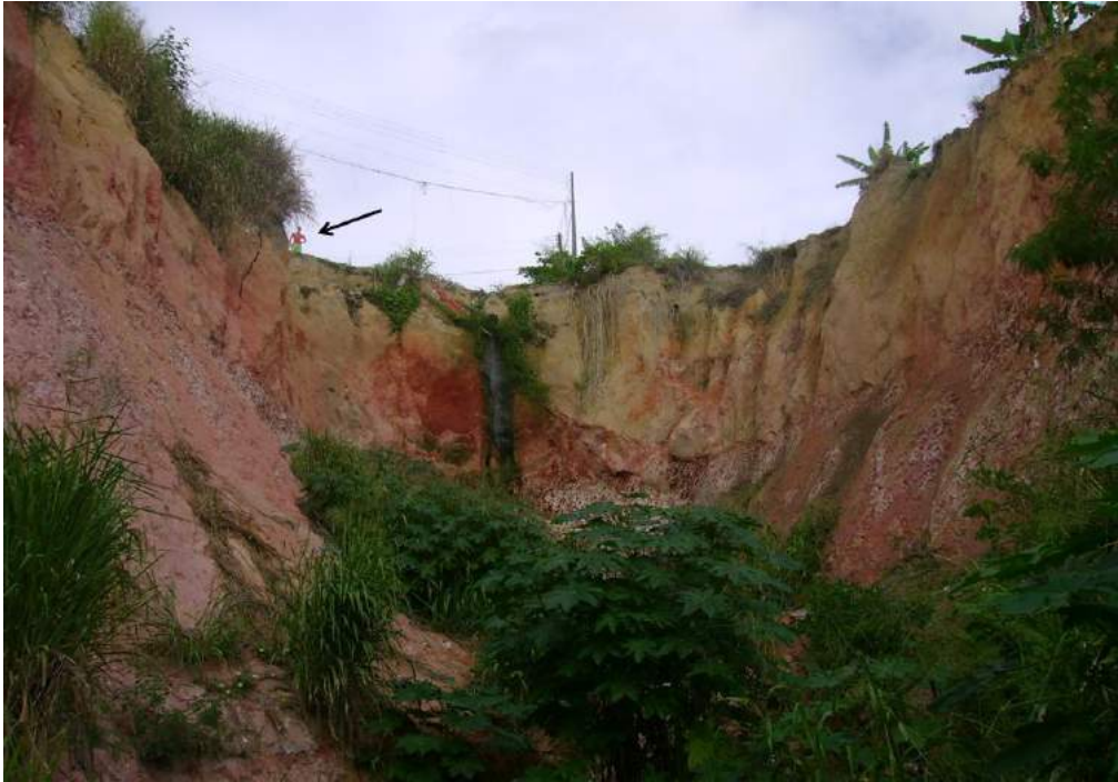
Figura 09. Vista da cabeceira da voçoroca principal a partir da sua foz. Em destaque uma pessoa na cabeceira evidenciando a dimensão da mesma.
