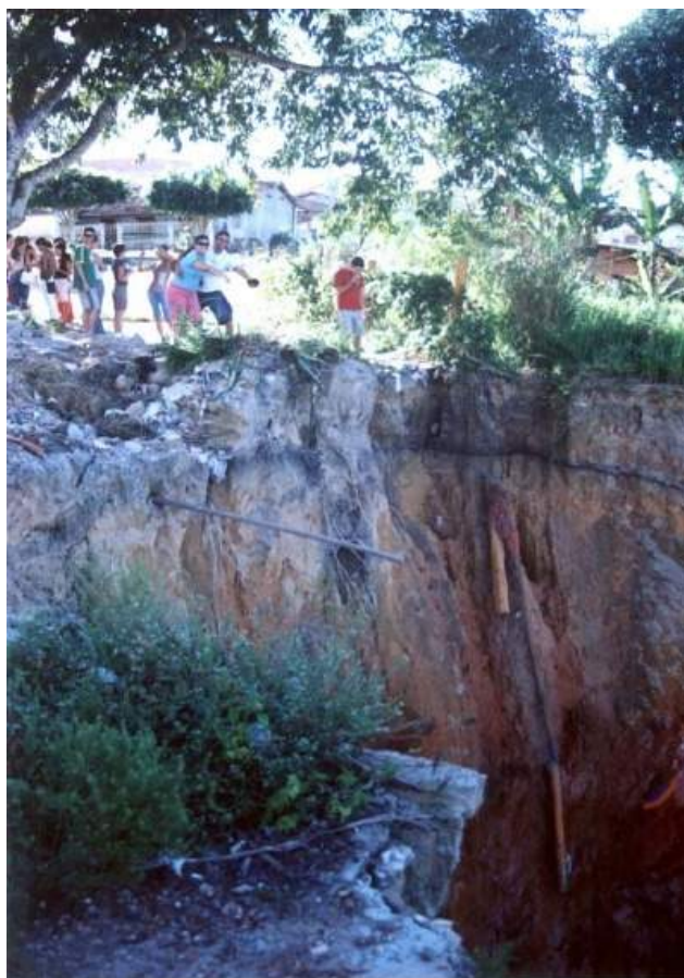
Figura 07. Cabeceira da voçoroca no bairro Urbis I ainda com a presença de grandes árvores no seu entorno (jul/2006).
