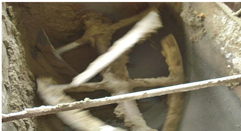
Figura 2: Processo de mistura dos agregados e aglomerantes
