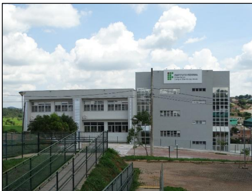
Figura 2 – Novo Bloco Didático – Campus Ribeirão das Neves.
