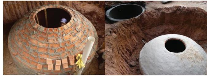
Figura 2 – Etapa de construção de um Biodigestor (OIA)
