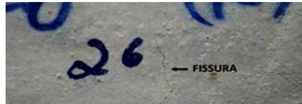
Figura 12 - Fissura em CP após Ensaio de Tração na Flexão
