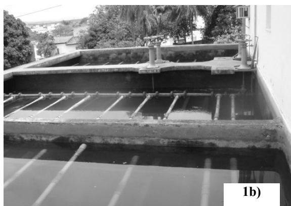
Figuras 1a e 1b. Vista do ponto de aplicação (PA) do sulfato de alumínio dentro da calha Parshall (1a) e do sistema de filtração (1b) na ETA do SAAE – Itapetinga.
