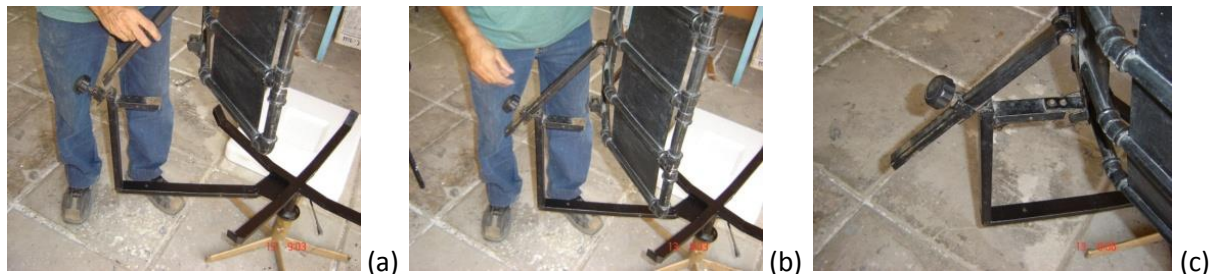
Figura 9 - Montagem da superfície refletora externa e de sua fixação a base do forno/fogão solar.
